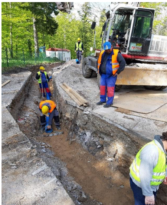
©SECO / Travaux de construction du réseau d'eau au Gorski Kotar
